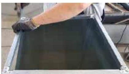
Postavljanje prirubnice na kanal
